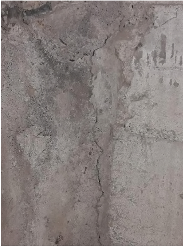
Նկար 22: No.4 հենարանի խցի ներսում ուղղահայած պատում առկա ճաքեր պատկերներ:
