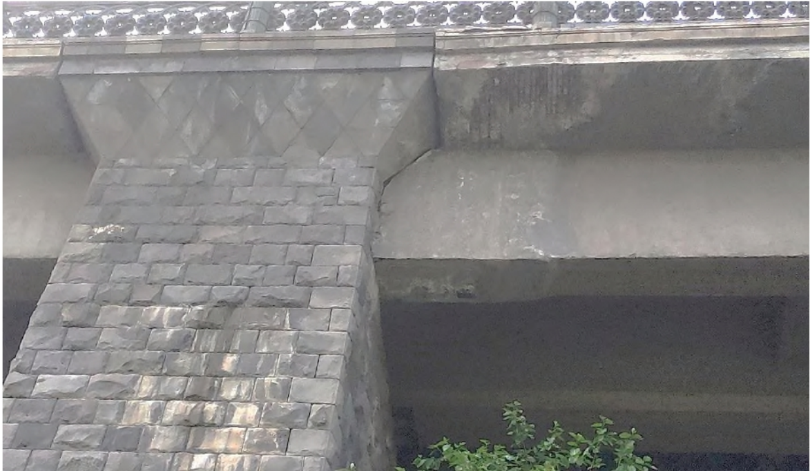
Նկար 15: Հեծանային թռիչքային կառուցվածքի կոնսոլային հատվածի ու հեծանի եզրային հատվածի վնասվածքներ դեֆորմացիոն կարի խախտման հետքերով ներխուժող ջրերի հետքերով:
