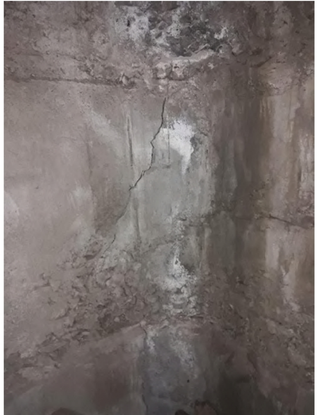
Նկար 22: No.4 հենարանի խցի ներսում ուղղահայած պատում առկա ճաքեր պատկերներ:
