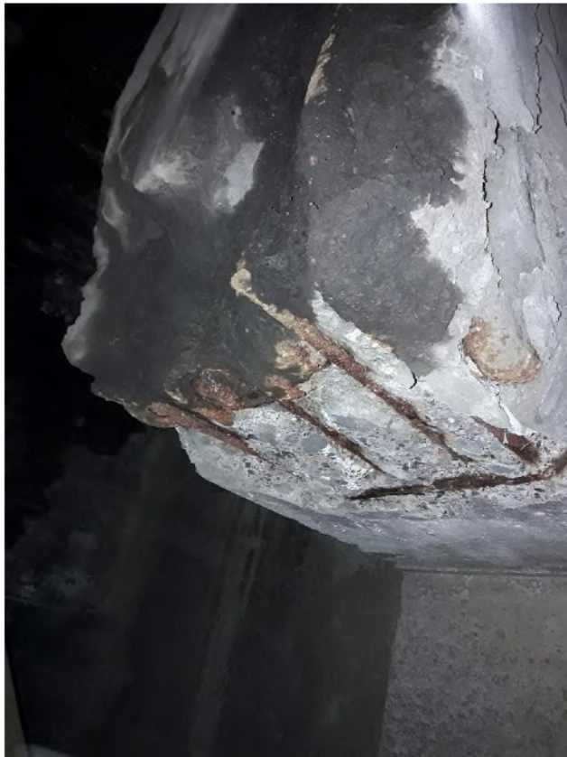
Նկար 16: No.3 հենարանի հատվածում հեծանային թռիչքային կառուցվածքի եզրային գլխավոր հեծանի կոնսոլի բետոնի քայքայում, ամրանի կոռազիա դեֆորմացիոն կարից ներխուժող ջրերի հետևանքով:
