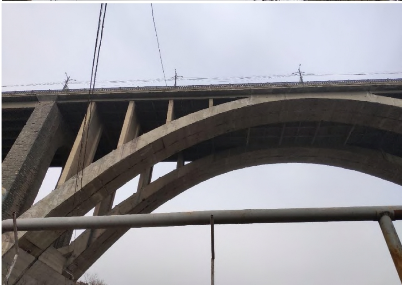
Նկար 12: Կամարային կամրջի կամարների արտաքին մակերեսների վրա առկա են անձրևաջրերի ազդեցության հետքեր
