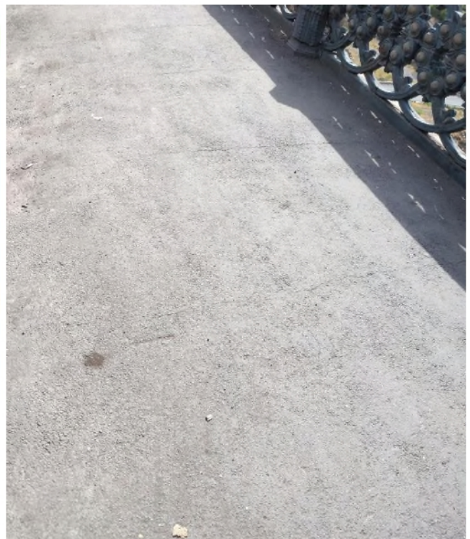
Նկար 3: Մայթերում, հավաքովի ե/բետոնե սալերի միջև կարանների հատվածում ճաքեր ա/բետոնե ծածկույթում:
