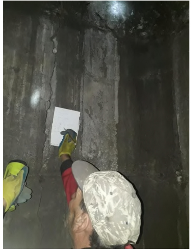
Նկար 18: No.2 հենարանի խցի պատերում ներսի կողմից ուղղահայած ճաքերի պատկերներ:
