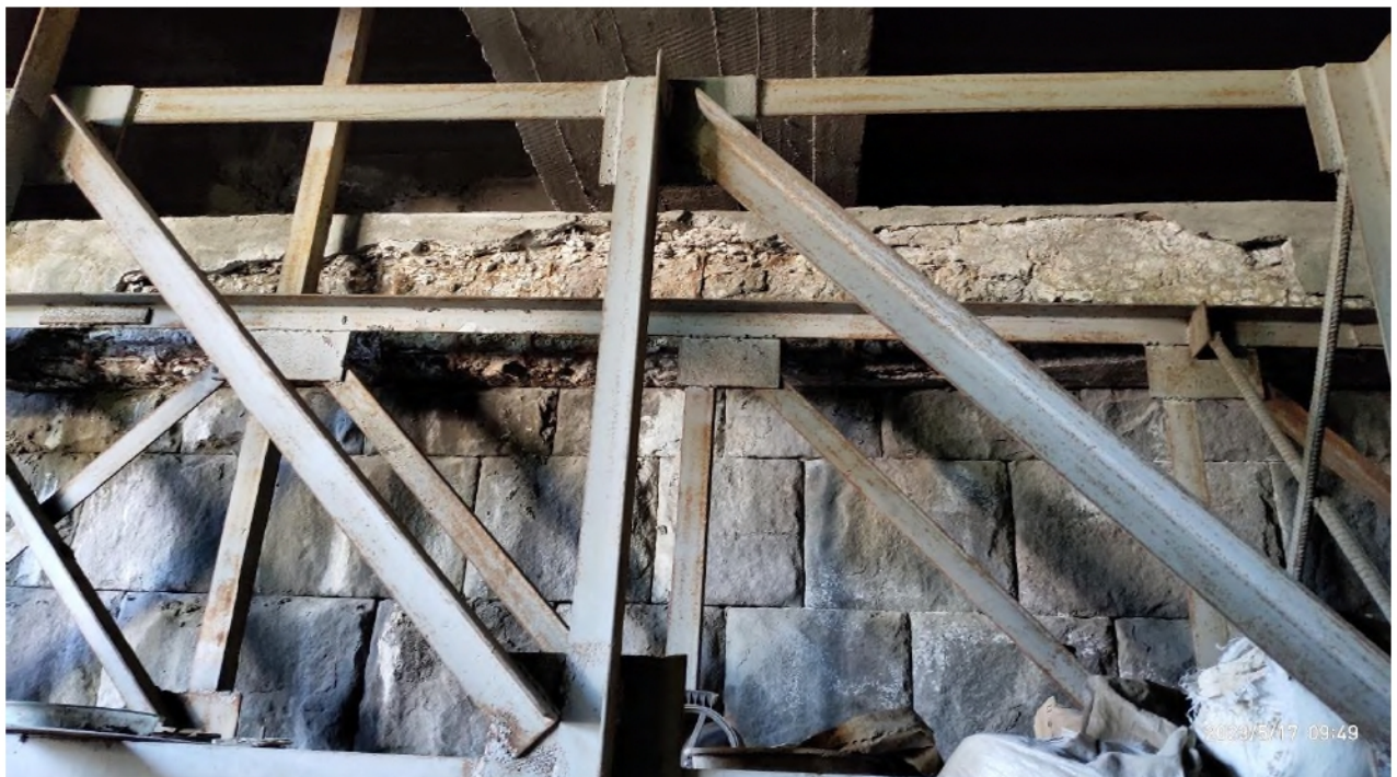
Նկար 17: Ափային հենարանի, հենարան 1-ի, ֆերմասալի վնասված պաշպանիչ շերտ:
