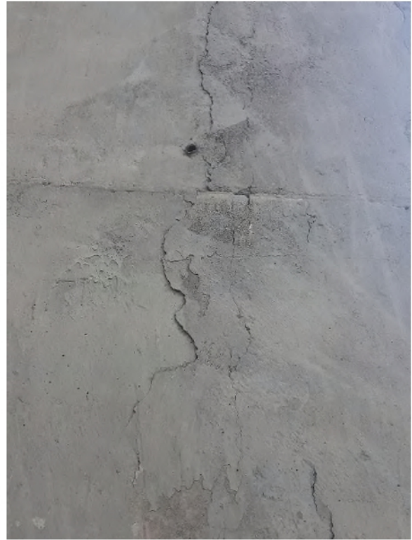
Նկար 26: No.5 Հենարանի խուճի ներքին կողմից պատերում ուղղահայած ճաքեր:
