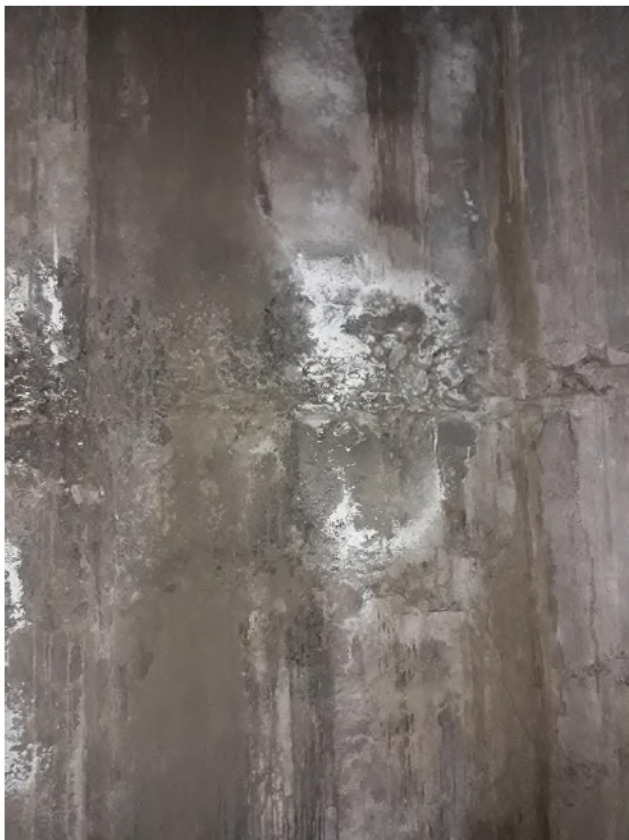
Նկար 27: No.5 հենարանի խուճերի ներքին հատվածներում ջրերի ներխուժման հետքեր, որոշ հատվածներում առկա է ցեմենտագրցման երևույթներ:
