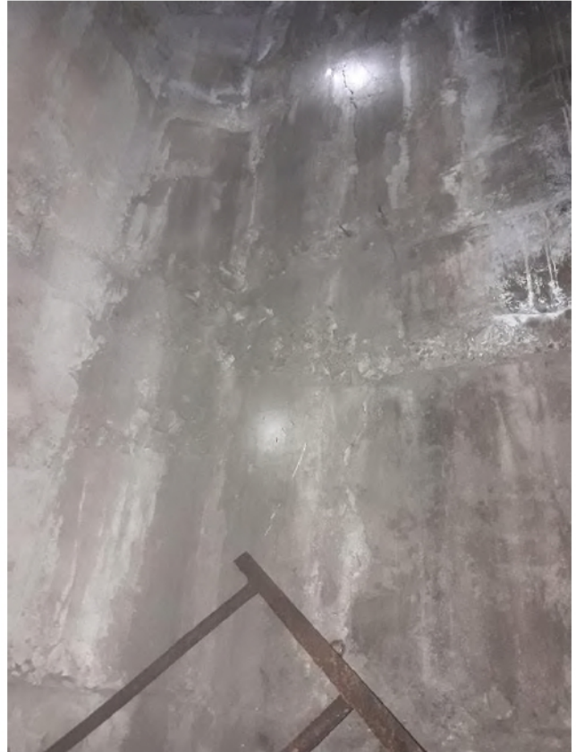
Նկար 27: No.5 հենարանի խուճերի ներքին հատվածներում ջրերի ներխուժման հետքեր, որոշ հատվածներում առկա է ցեմենտագրցման երևույթներ:
