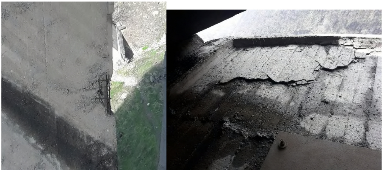
Նկար 11: Կամարի բետոնի տիպիկ վնասվածքներ՝ անկյունային հատվածների վնասվածքներ մինչև ամրանի մերկացում, վերին մակերեսներում պաշպանիչ շերտի շերտավորում:
