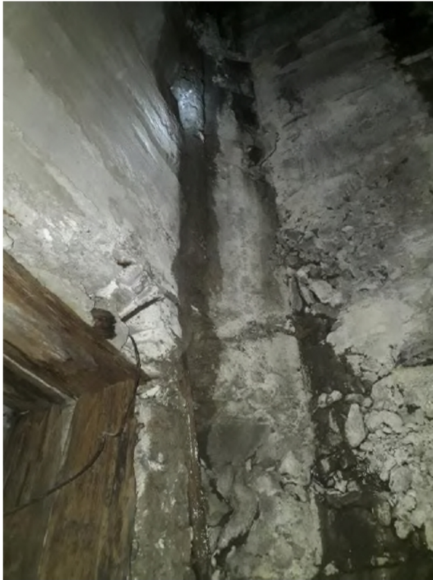
Նկար 18: No.2 հենարանի խցի պատերում ներսի կողմից ուղղահայած ճաքերի պատկերներ:
