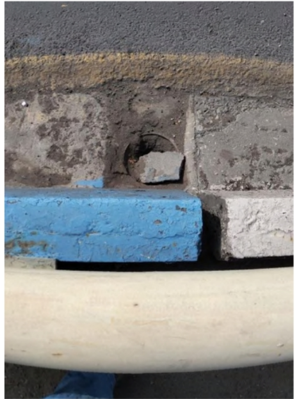
Նկար 2: Ջրագեռացման խողովակների ջրընդունիչները փաթ են կեղտով ու ավազով (հիմնականում գետի ջրի հոսքի ստորին կողմից):
