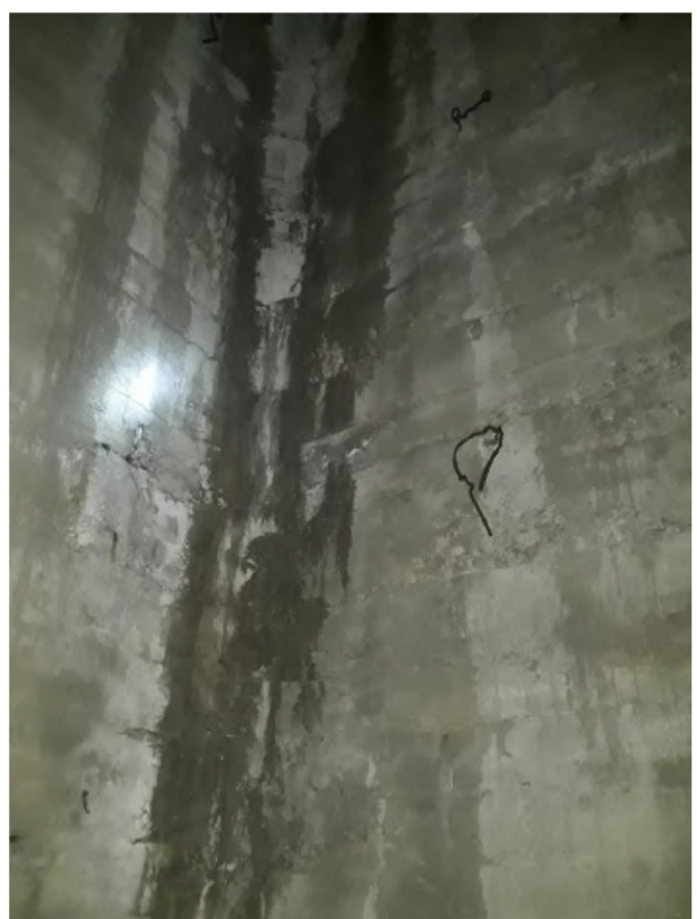
Նկար 19: No.2 հենարանի խուցերի ներքին հատվածներում ջրերի ներխուժման հետքեր, որոշ հատվածներում առկա է ցեմենտի լվացագերծման երևույթներ:
