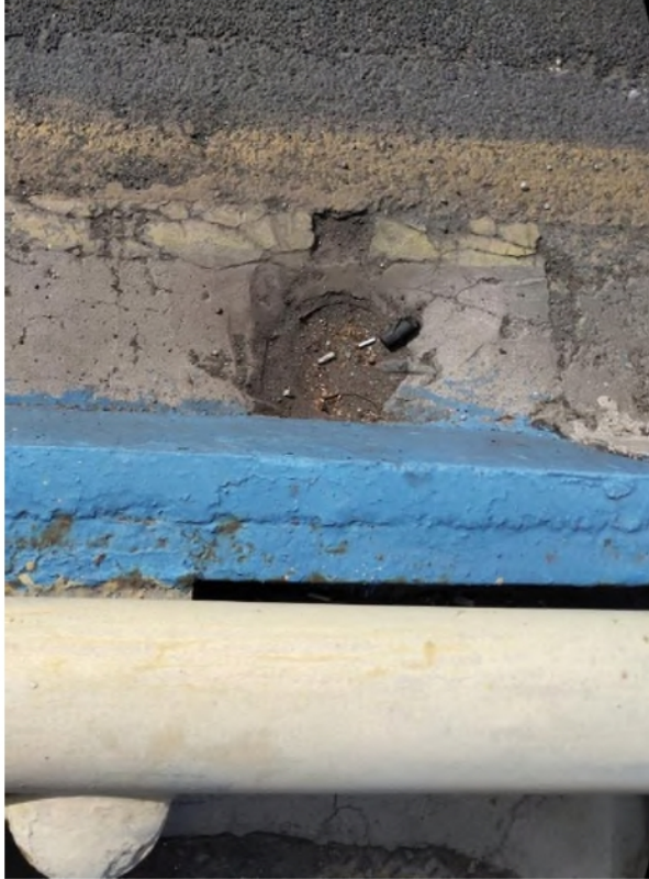
Նկար 2: Ջրագեռացման խողովակների ջրընդունիչները փաթ են կեղտով ու ավազով (հիմնականում գետի ջրի հոսքի ստորին կողմից):
