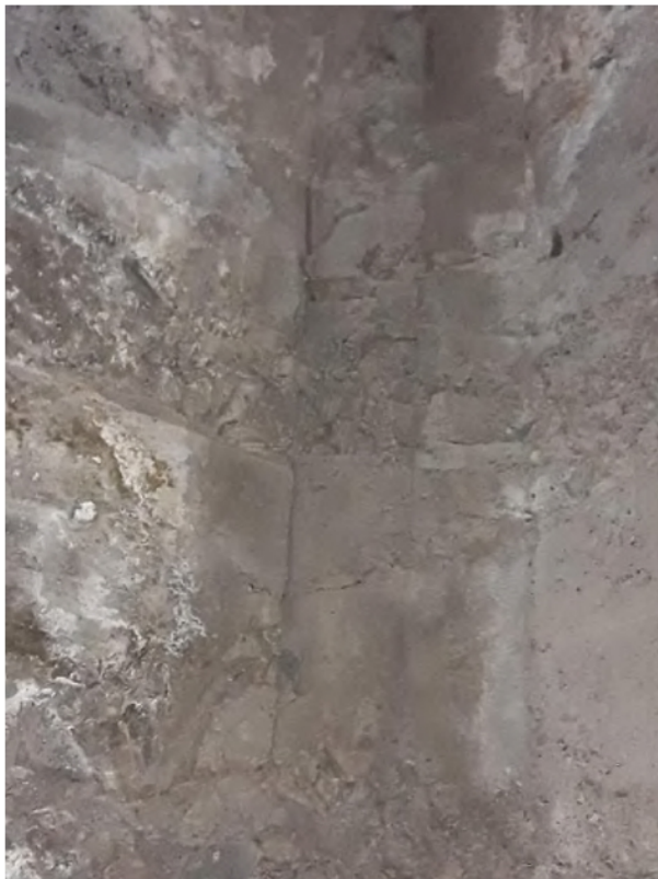
Նկար 23: No.4 հենարանի խուցերի ներքին հատվածներում ջրերի ներխուժման հետքեր, որոշ հատվածներում առկա է ցեմենտազրցման երևույթներ:
