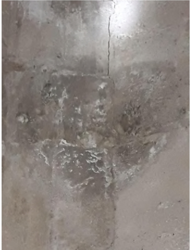
Նկար 23: No.4 հենարանի խուցերի ներքին հատվածներում ջրերի ներխուժման հետքեր, որոշ հատվածներում առկա է ցեմենտազրցման երևույթներ:
