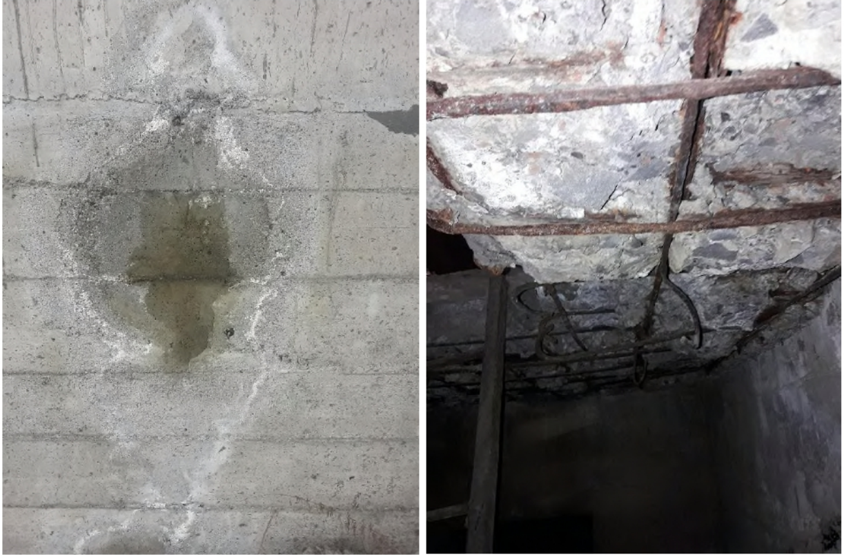
Նկար 24: No.4 հենարանի խուցերի ներքին հատվածներում ջրերի ներխուժման հետքեր, հորիզոնական դիաֆրագմային մակերեսի պաշտանիչ բետոնի քայքայում, ամրանի մերկացում ու կոռոզիա:
