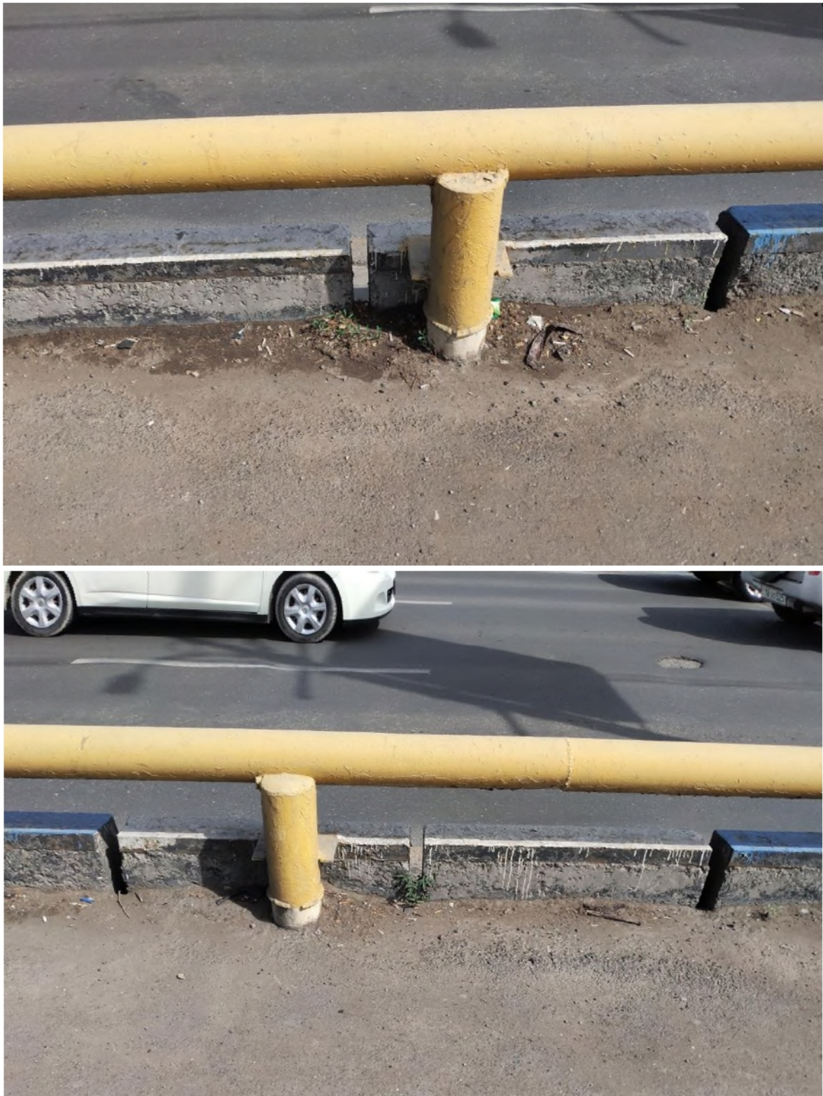
Նկար 7: Պարապետային տիպի արգելապատնեշի հավաքովի ե/բետոնե բլոկների միջև մայթերից ջրահեռացման նպատակով թողնված բացվածքների մուտքը փաթված է կեղտով ու ավազով, որոշ տեղերում առկա է խոտի աճ:
