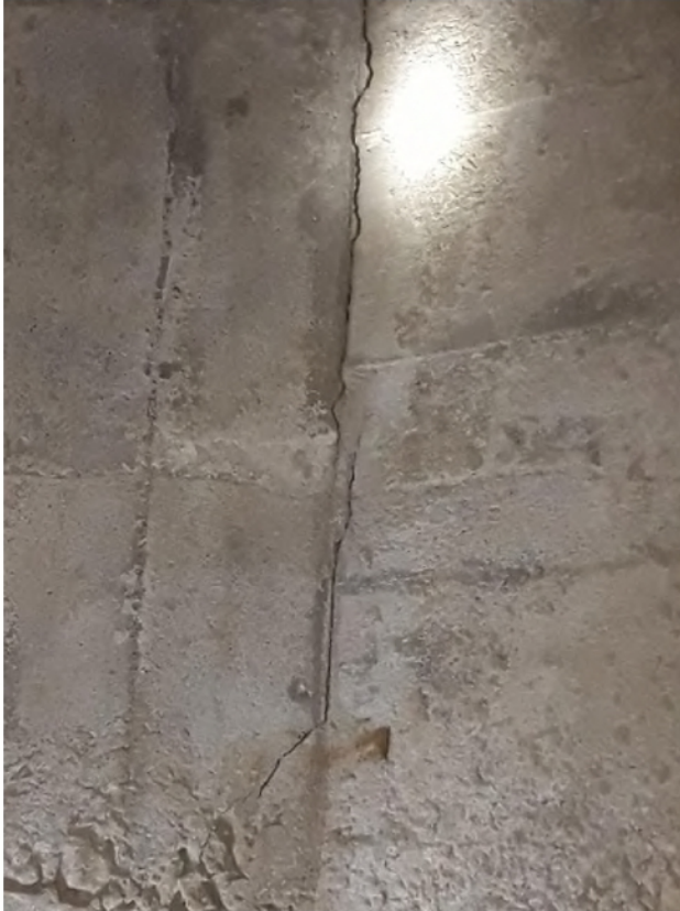
Նկար 20: No.3 հենարանի խցի պատերում ներսի կողմից ուղղահայած ճաքերի պատկերներ:
