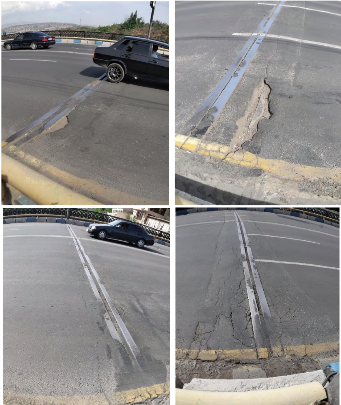
Նկար 1: Դեֆորմացիան կարերի կցորդման հատվածներում ա/բետոնե ծածկույթը վնասված է, քիտումային մածուկով կարի բացվածքը բացակայում է, եզրային տարրերը տեղ տեղ թույլացված են և պոկված, խախտված է եզրային տարրերի միմյանց նկատմամբ ու ա/բետոնի ըստ բարձրության դիրքերը:
