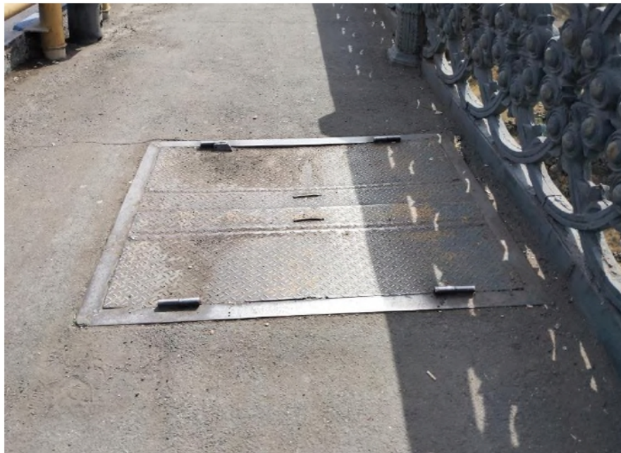
Նկար 4: Կոմունիկացիոն խողակների դիտահոր:
