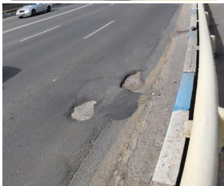
Նկար 8: Երթուղեկելի մասի ծածկույթի վնասվածներ:
