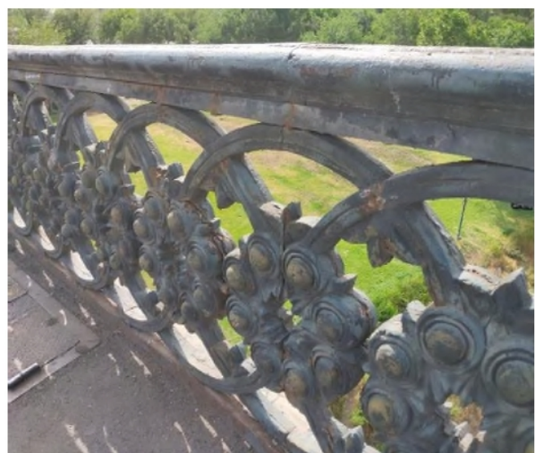
Նկար 5: Բազրիքների ներկա վիճակը, կանգնակային մասի թուլեց երեսապատման տարրերում առկա են ճաքեր, որոշ հատվածներում բացվել են կարաններ թուլեց տարրերի միջև:
