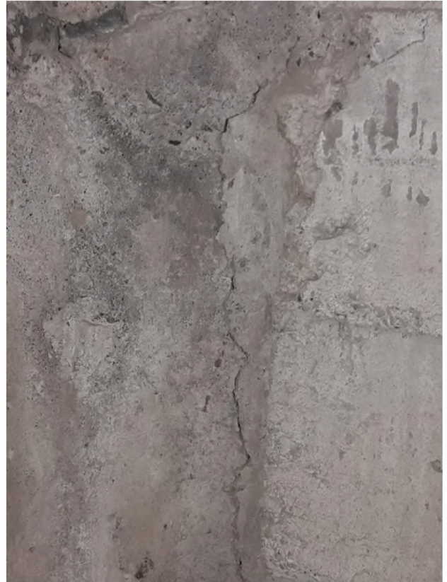
Նկար 20: No.3 հենարանի խցի պատերում ներսի կողմից ուղղահայած ճաքերի պատկերներ:
