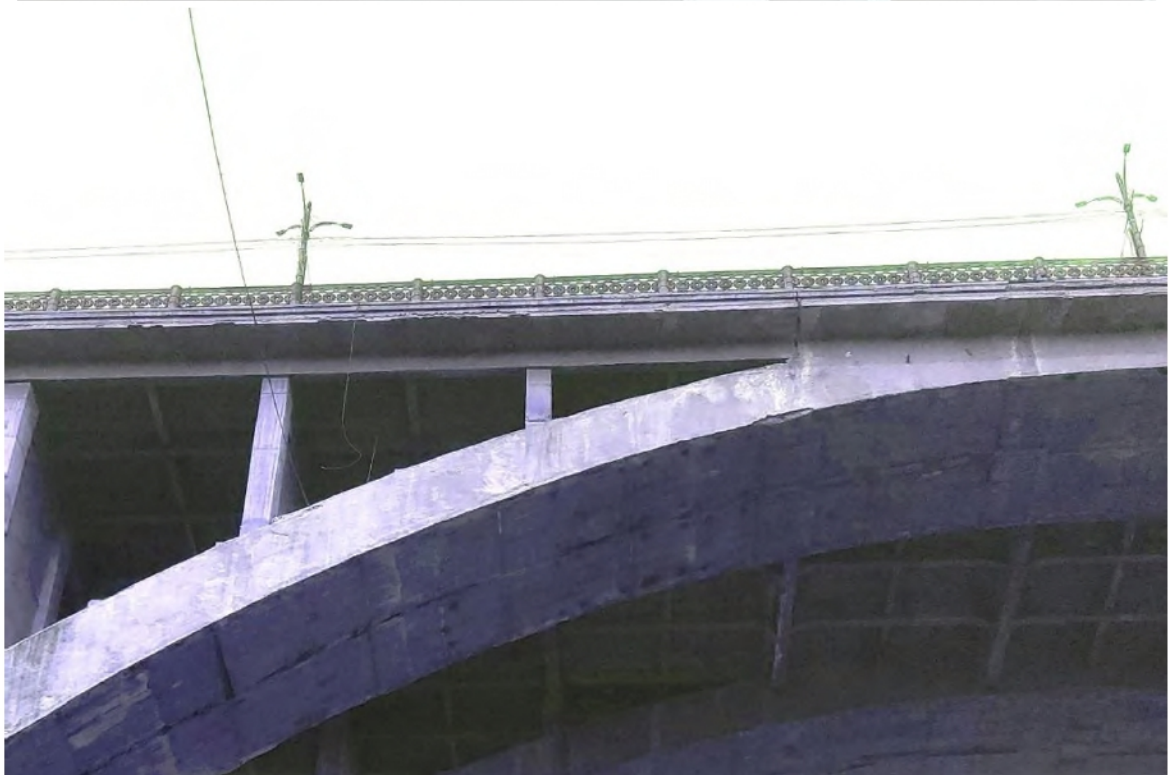
Նկար 13: Կամարային կամրջի կամարների արտաքին մակերեսների վրա առկա են անձրևաջրերու ազդեցության հետքեր, վերկամարային թռիչքային կառուցվածքի կոնսոլային հատվածներում առկա են հատվածներ վնասված բետոնե պաշտանիչ շերտով:
