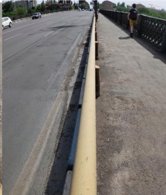
Նկար 6: Հավաքովի ե/բետոնե արրգելապատնեշների ստորին հատվածները քայքայված են, ամրանը մերկացած:
