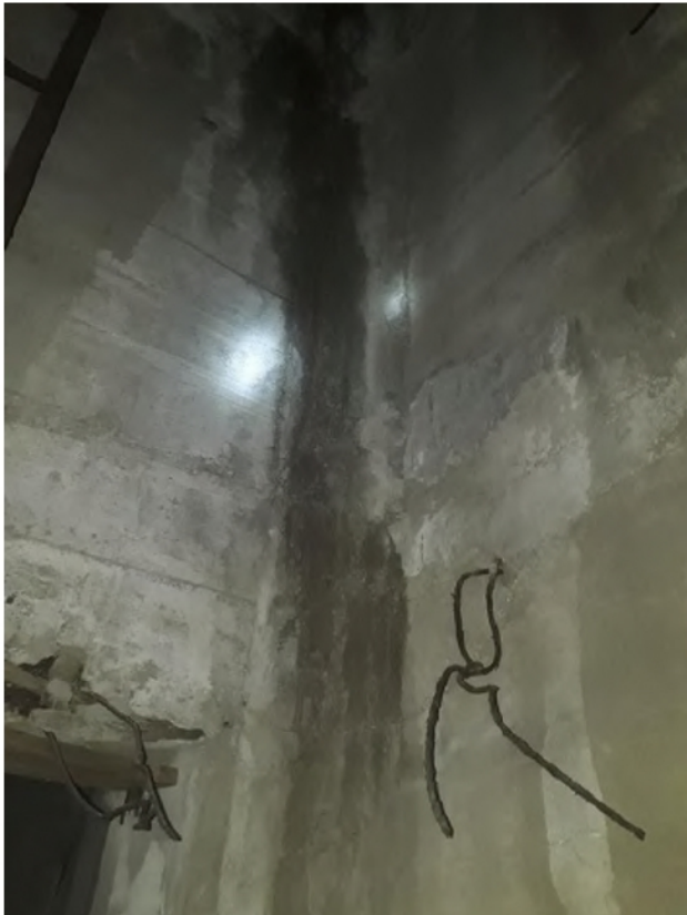
Նկար 19: No.2 հենարանի խուցերի ներքին հատվածներում ջրերի ներխուժման հետքեր, որոշ հատվածներում առկա է ցեմենտի լվացագերծման երևույթներ:
