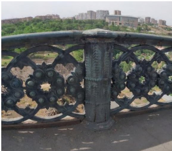
Նկար 5: Բազրիքների ներկա վիճակը, կանգնակային մասի թուլեց երեսապատման տարրերում առկա են ճաքեր, որոշ հատվածներում բացվել են կարաններ թուլեց տարրերի միջև:
