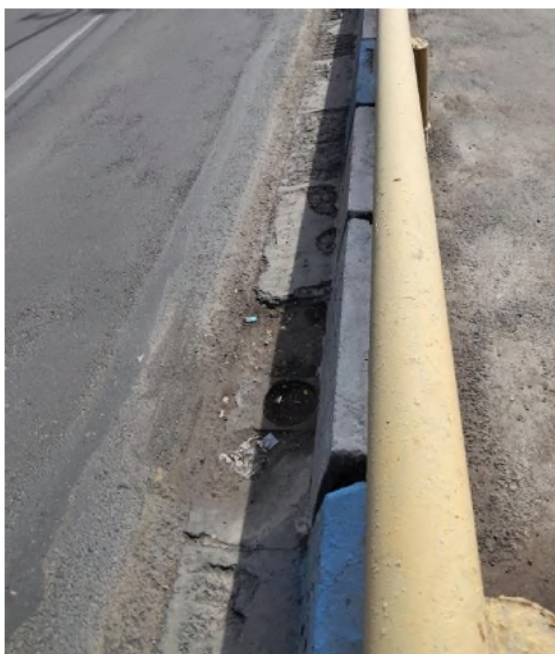
Նկար 6: Հավաքովի ե/բետոնե արրգելապատնեշների ստորին հատվածները քայքայված են, ամրանը մերկացած:
