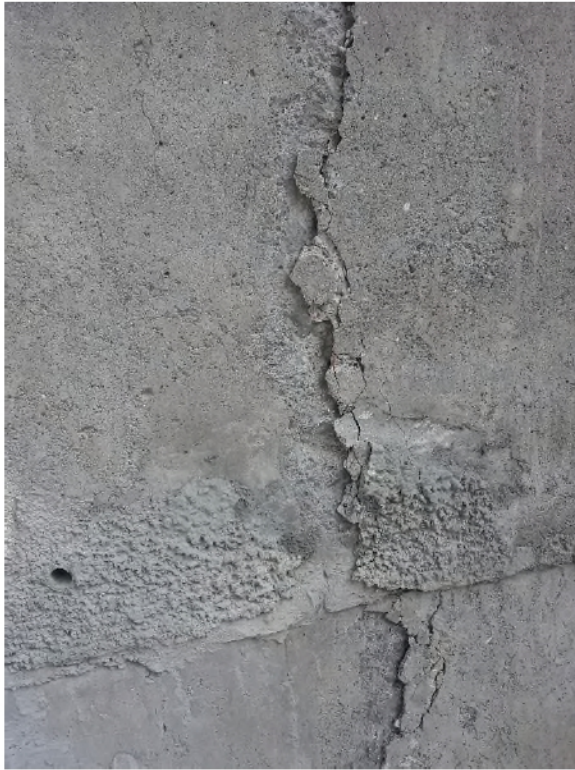
Նկար 26: No.5 Հենարանի խուճի ներքին կողմից պատերում ուղղահայած ճաքեր:
