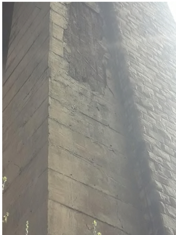
Նկար 25: No.5 հենարանի արտաքին մակերեսի բետոնի պաշտանիչ շերտը քայքաված է, ամրանը մեկուսացված:
